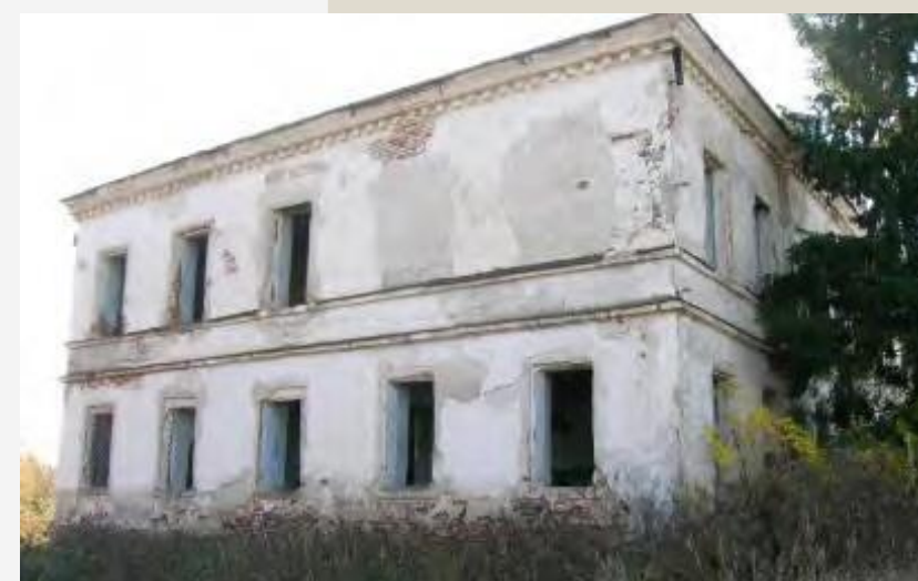
БОКОВОЙ ФАСАД ОСНОВНОГО КОРПУСА
