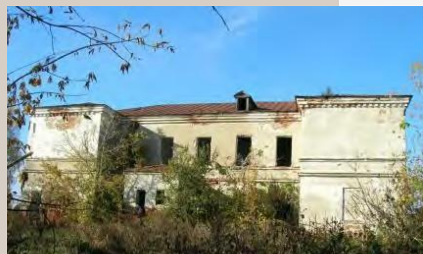
ЗАДНИЙ ФАСАД ОСНОВНОГО КОРПУСА
